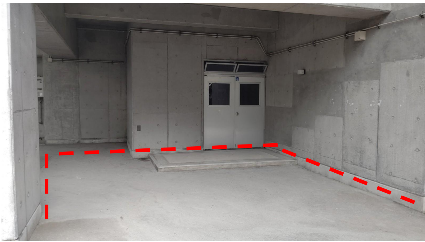
・1 階外、体育館裏側
